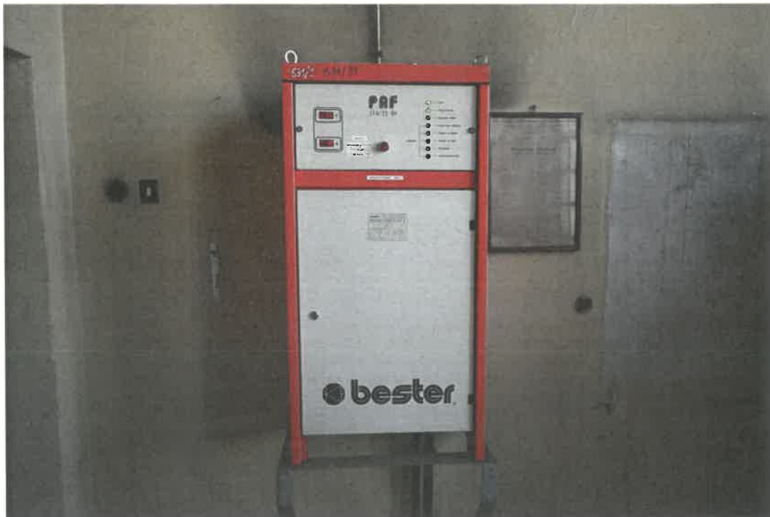
Zdjęcie 7. Przekształtnik tyrystorowy.
