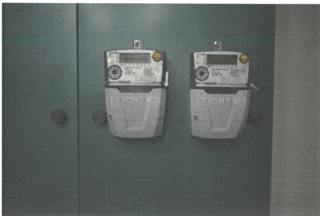
Zdjęcie 2. Układy pomiarowe kontrolno-bilansujące
