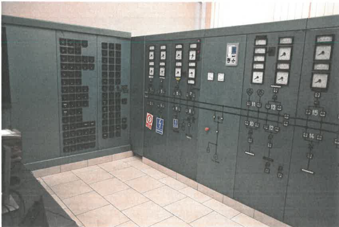
Zdjęcie 6. Szafy dwustronne z aparaturą sygnalizacyjną i zabezpieczającą oraz tablica z licznikami pomiarowymi w dyspozytorni.
