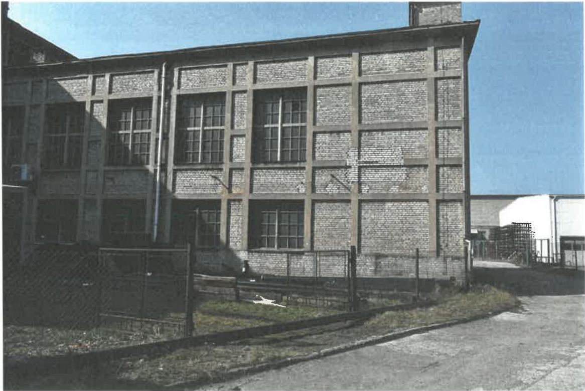
Zdjęcie 9. Budynek rozdzielni elektrycznej 6 kV.
